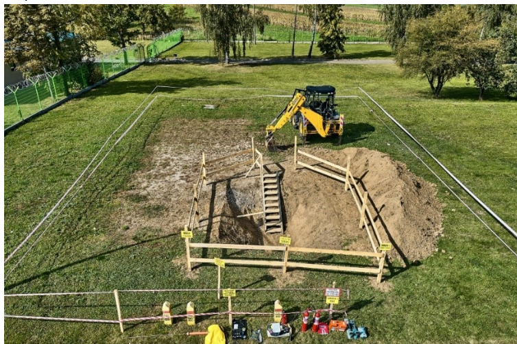
Rysunek 4 Przykład wygrodzenia, oznakowania i zabezpieczenia strefy pracy podczas realizacji prac ziemnych
